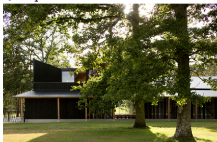
ATELIERS COMMUNAUX / LOGEMENT / CLUB-HOUSE POIGNY-LA-FORÊT // BOIDOT ET ROBIN ARCHITECTES © Clément Guillaume
