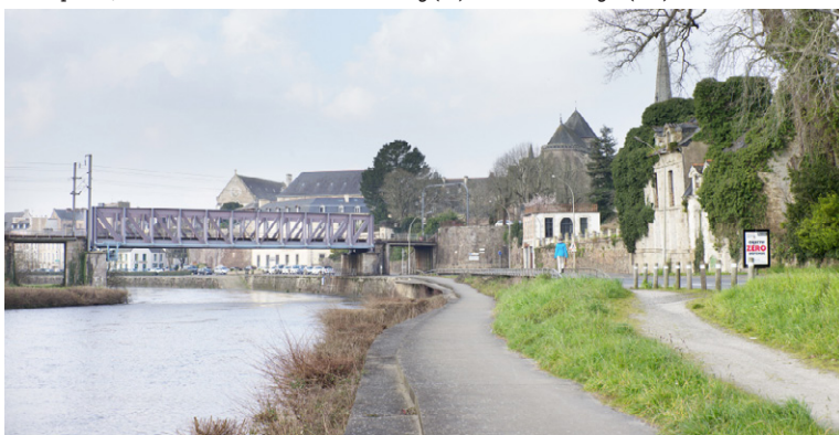
LDLV Pierre Lafond architecte // Digue anti-crue - Redon (35) // © Patrick Messina (FTL)
