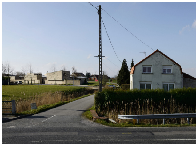
Pierre Bernard, architecte // Béguinage - Vieille Eglise (62) // © Guillaume Amat (FTL)
