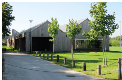
SALLE DE FÊTES / VESTIAIRES - BREUIL-BOIS-ROBERT KÉROSÈNE ARCHITECTES
